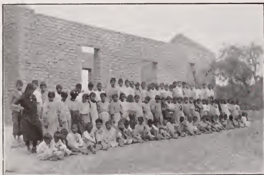
LA ESCUELA EN CONSTRUCCIÓN
